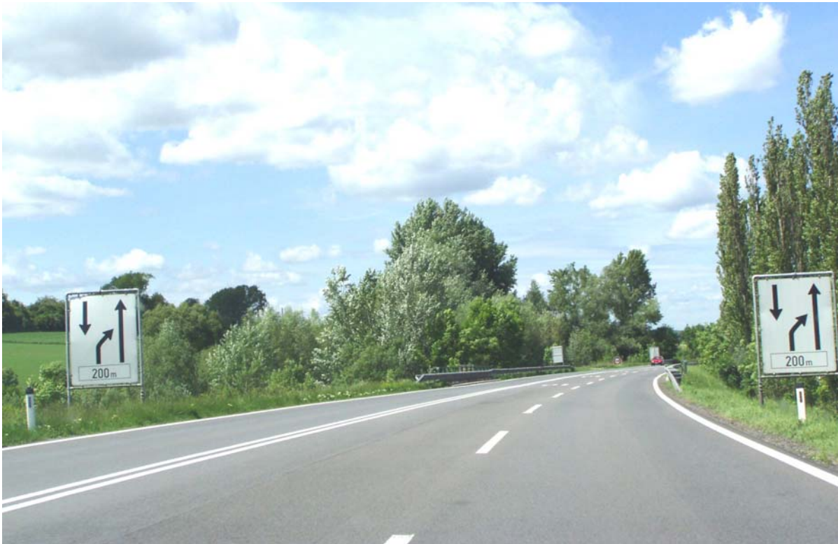
Obr. 11: Třípruhové uspořádání na rakouské rychlostní silnici S 3 v úseku Stockerau-Hollabrun, návěstní tabule před místem střídání směru dopravy
