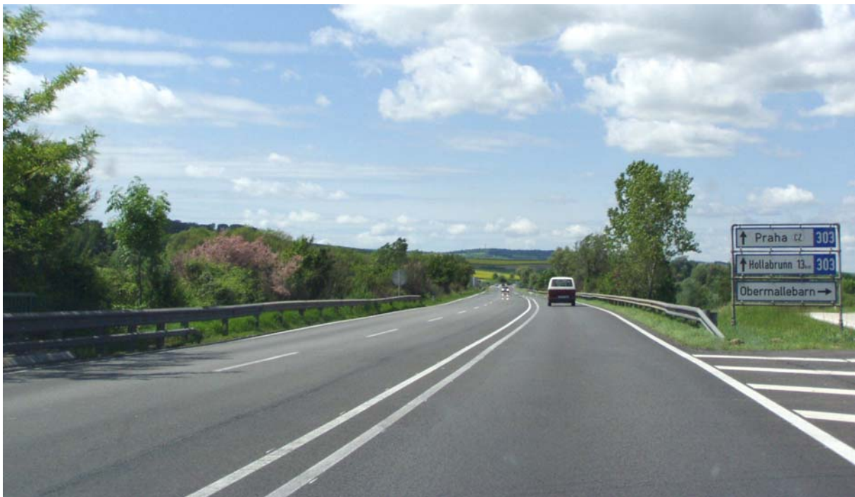
Obr. 1: Příklad třípruhového uspořádání na rakouské rychlostní silnici S3 v úseku Stockerau-Hollabrunn
