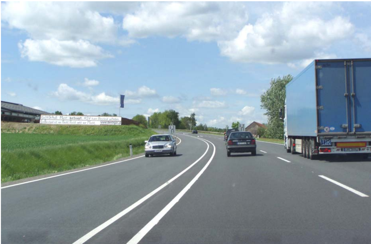
Obr. 12: Třípruhové uspořádání na rakouské rychlostní silnici S 3 v úseku Stockerau-Hollabrun, zdůrazněná dvojitá souvislá čára
