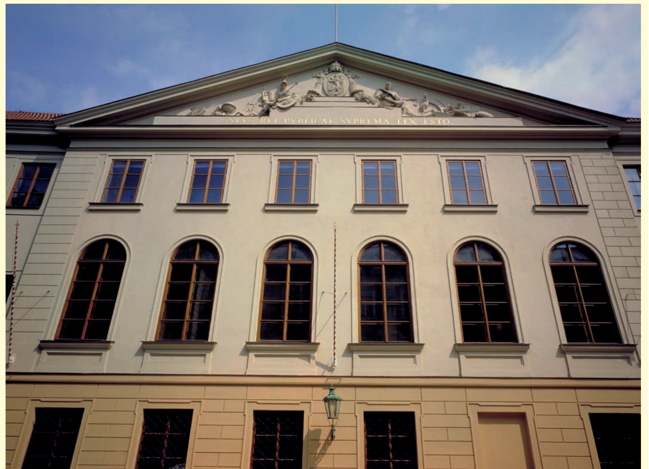
Pohled na střední část průčelí Thunovského paláce s tympanonem
